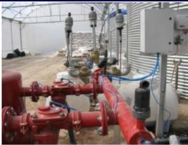
تزریق کود با استفاده از پمپ دیافراگمی با استفاده از نیروی مکش سیستم آبیاری
